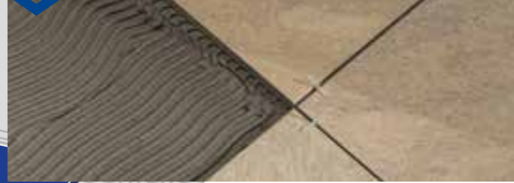
03 УКЛАДКА НА СТЯЖКУ / ON SUB-FLOOR
