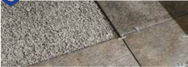
02 УКЛАДКА НА ГРАВИЙ / ON GRAVEL
